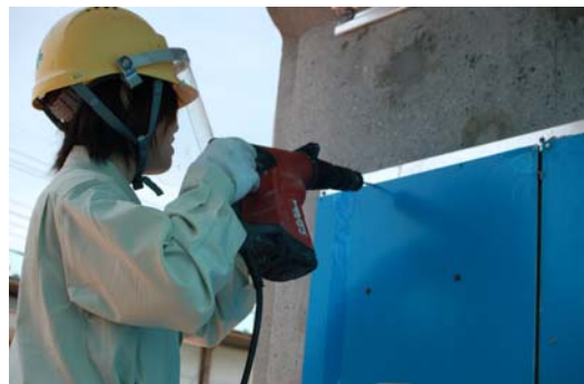
写真-3 陽極取付け状況
