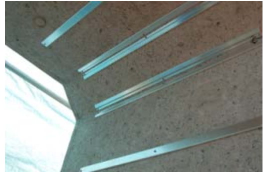
写真-2 施工準備
