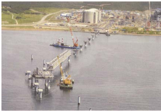
写真-2 LNG出荷栈橋 4)
