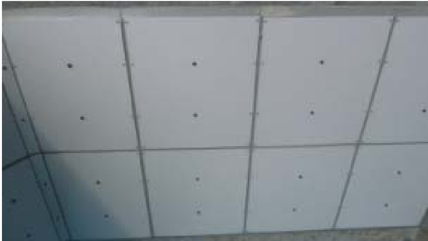
写真-5 試験施工 1
