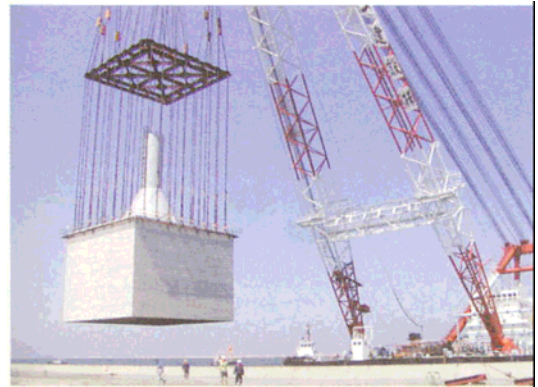
写真-3 コンクリート基礎上の防護コン鋼管杭 4)
