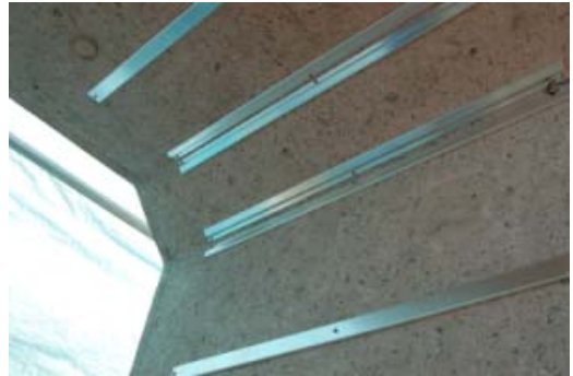
写真-2 施工準備
