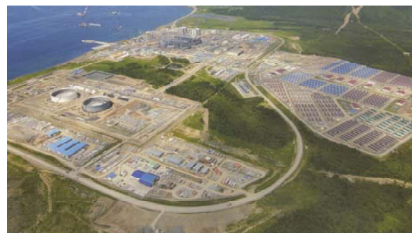
写真-1 サハリン2 LNG プラント 4)
