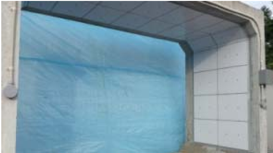
写真-6 試験施工 2
