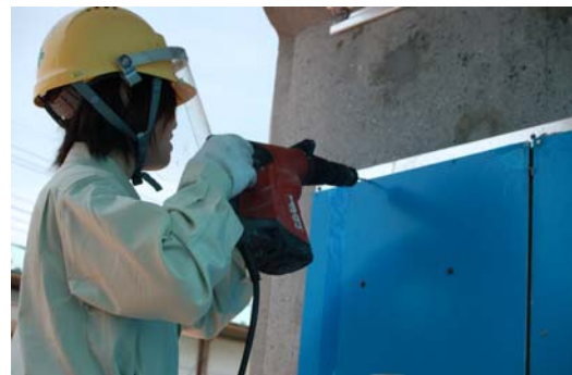
写真-3 陽極取付け状況
