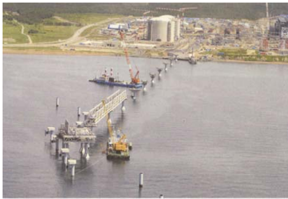
写真-2 LNG出荷栈橋 4)
